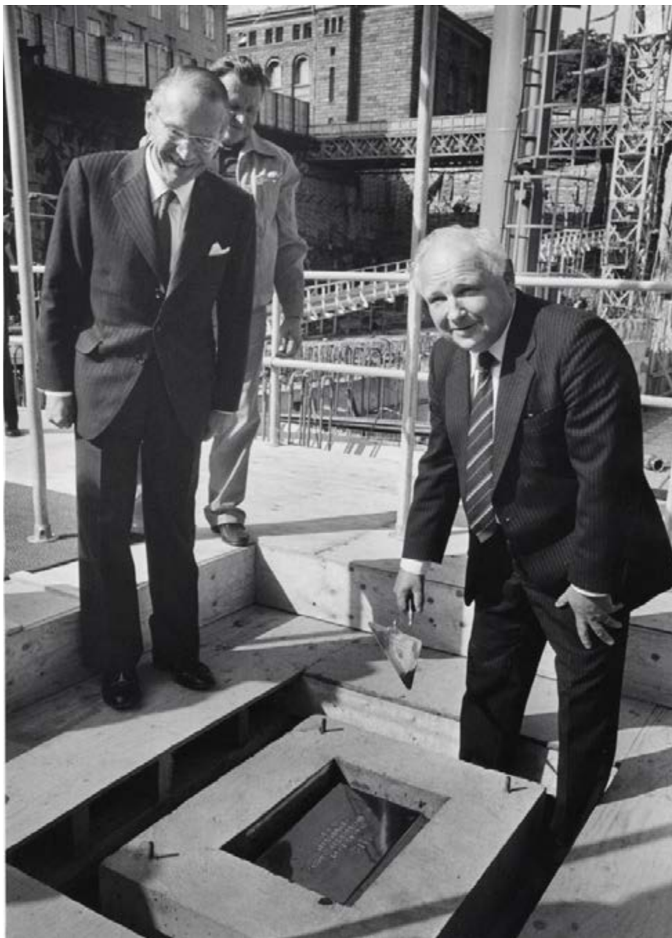
Bilde 12 Nedleggelse av grunnsteinen, Bankplassen 27. august 1982. Fra venstre Knut Getz Wold, Per Hysing-Dahl (stortingspresident), i bakgrunnen Hermann Bratvold (representant for entreprenøren). Foto: Privat.
